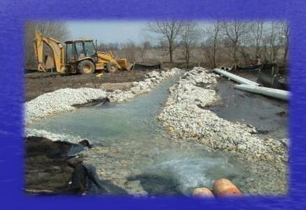
7. WATER PUMPED DURING CONSTRUCTION OPERATION SHALL BE FILTERED.
